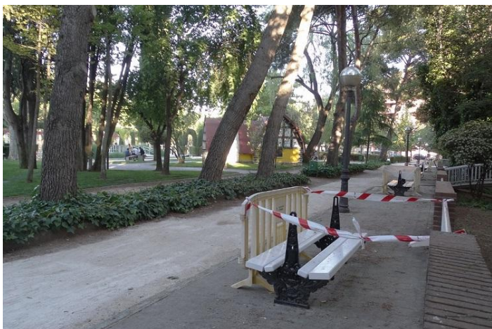
El parque Miguel Servet de Huesca en obras.
